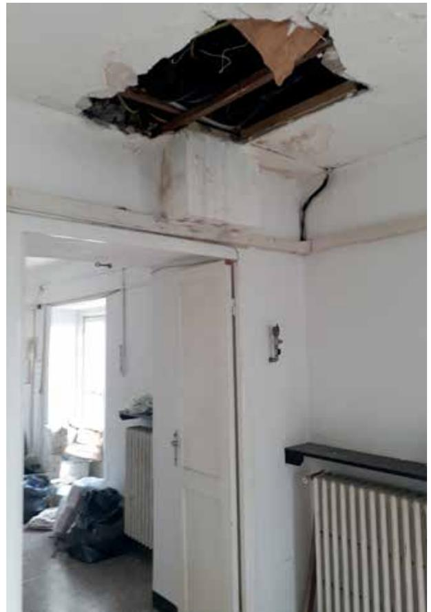
*Vista di situazioni puntali di degrado e distacco di intonaci rilevate al sesto piano dovute alle infiltrazioni dalla terrazza in copertura*
