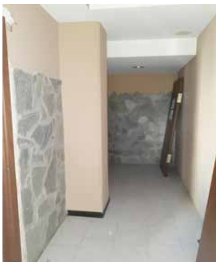
Vista dei locali interni posti al primo piano
