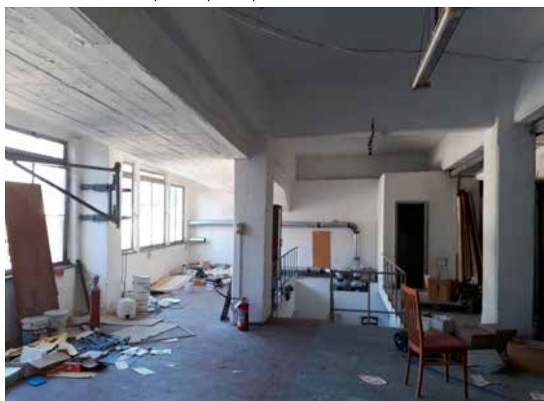
Vista del locale posto al secondo piano
