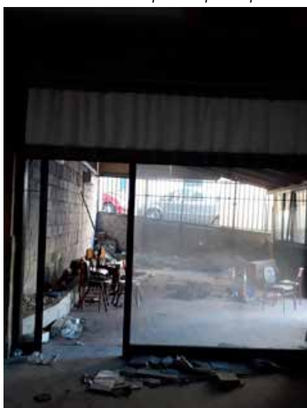
Vista della veranda dal locale al piano terra
