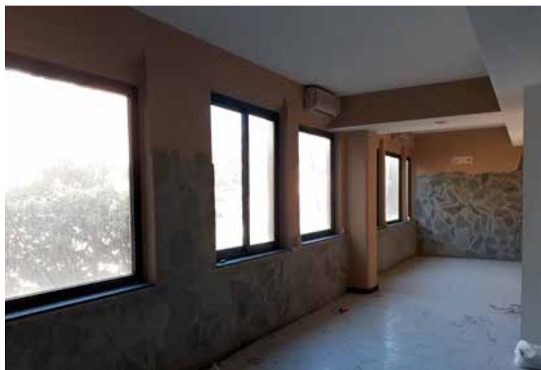
Vista dei locali interni posti al primo piano
