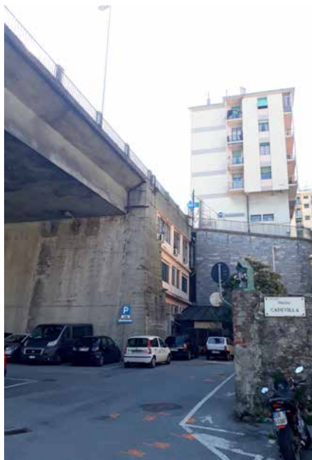
Vista di piazza Cadevilla e dell'immobile
