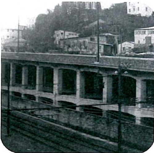
Nel 1931 iniziarono i lavori di realizzazione del progetto dell'ing. Braccialini per la strada di collegamento Levante-centro città. Si tratta di una nuova arteria sopraelevata, poggiata anziché sul terreno di riporto sostenuto da un muraglione a valle, sopra un solido solettone di cemento sotto il quale tutto lo spazio, suddiviso in più piani potesse essere utilizzato.
