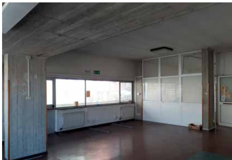
Vista di uno dei due ampi locali con finestre a nastro rivolte a ovest
