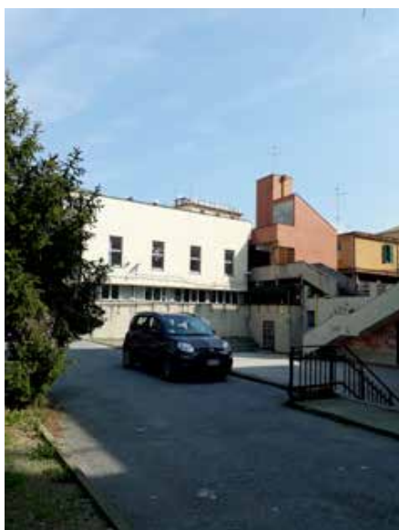
Scorcio del fronte sud e del corpo scala esterno
