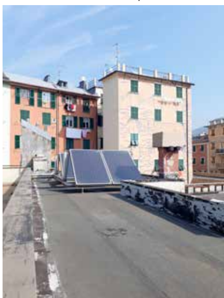
Vista del lastrico di copertura
