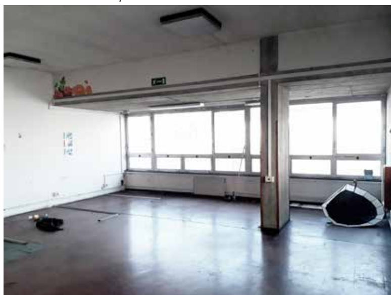
Vista di uno dei due ampi locali con finestre a nastro rivolte a ovest
