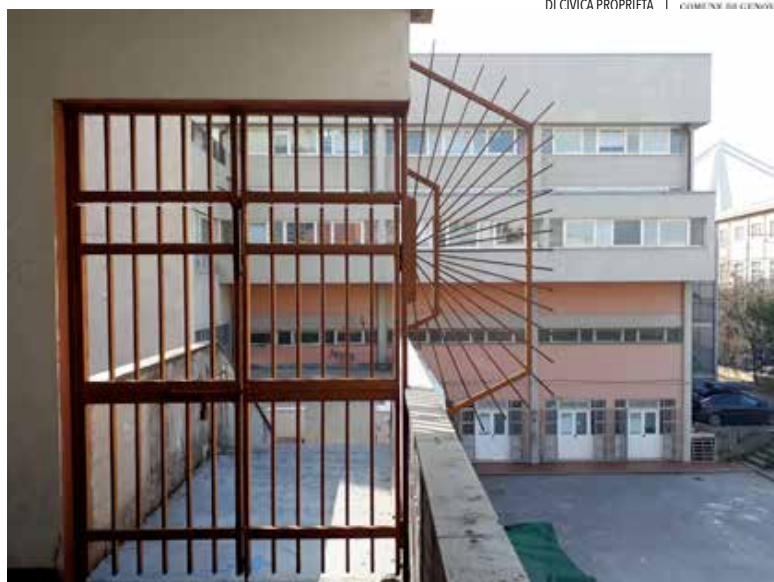
Dettaglio del cancello di collegamento con le aree esterne della scuola media Cafaro
