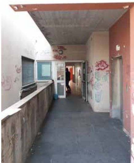
Vista dell'ingresso principale a sud
