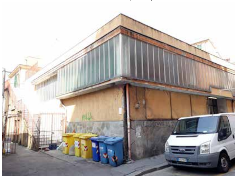
Scorcio dell'edificio che ospita il mercato coperto posto a est con accesso da via Certosa
